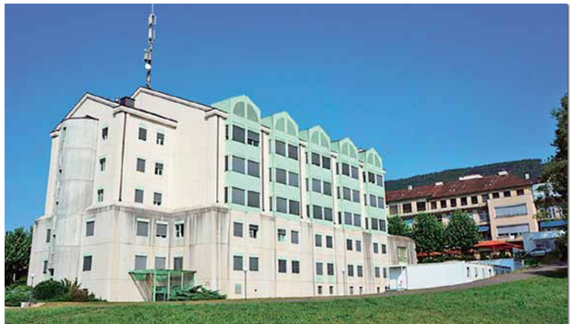
L'hôpital de Delémont, au coeur de la planification hospitalière.
