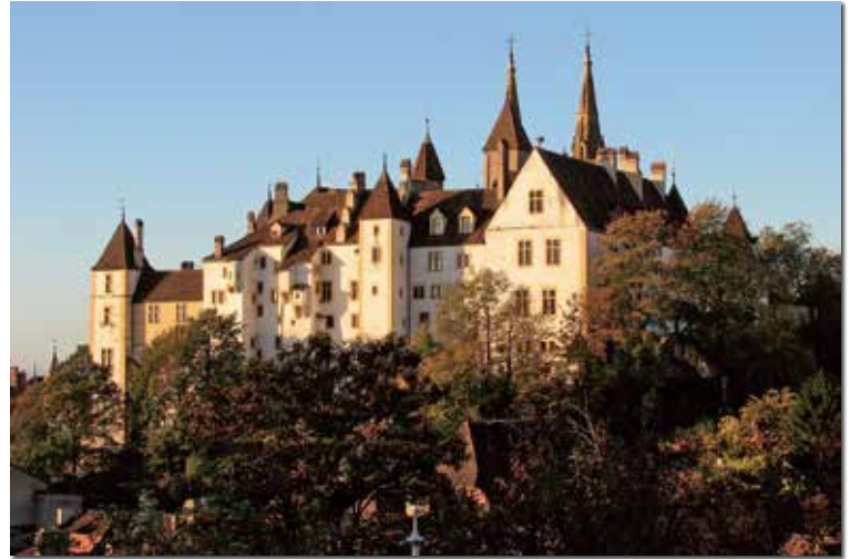
Le château de Neuchâtel, siège du gouvernement neuchâtelois sans cesse dans la tourmente.
